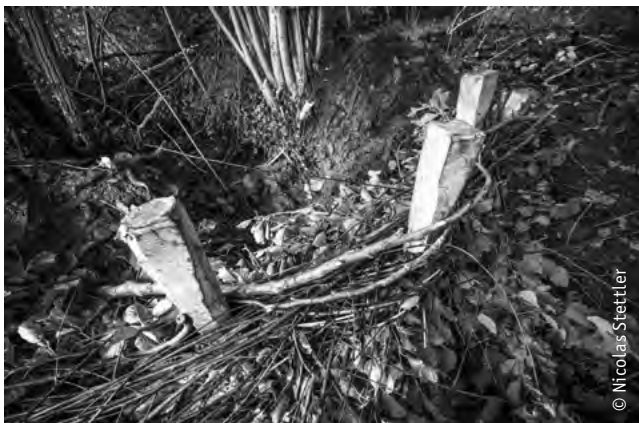
Die mit vielen Freiwilligen geschaffenen Flechtdämme sorgen für die Vernässung von Waldstandorten.
